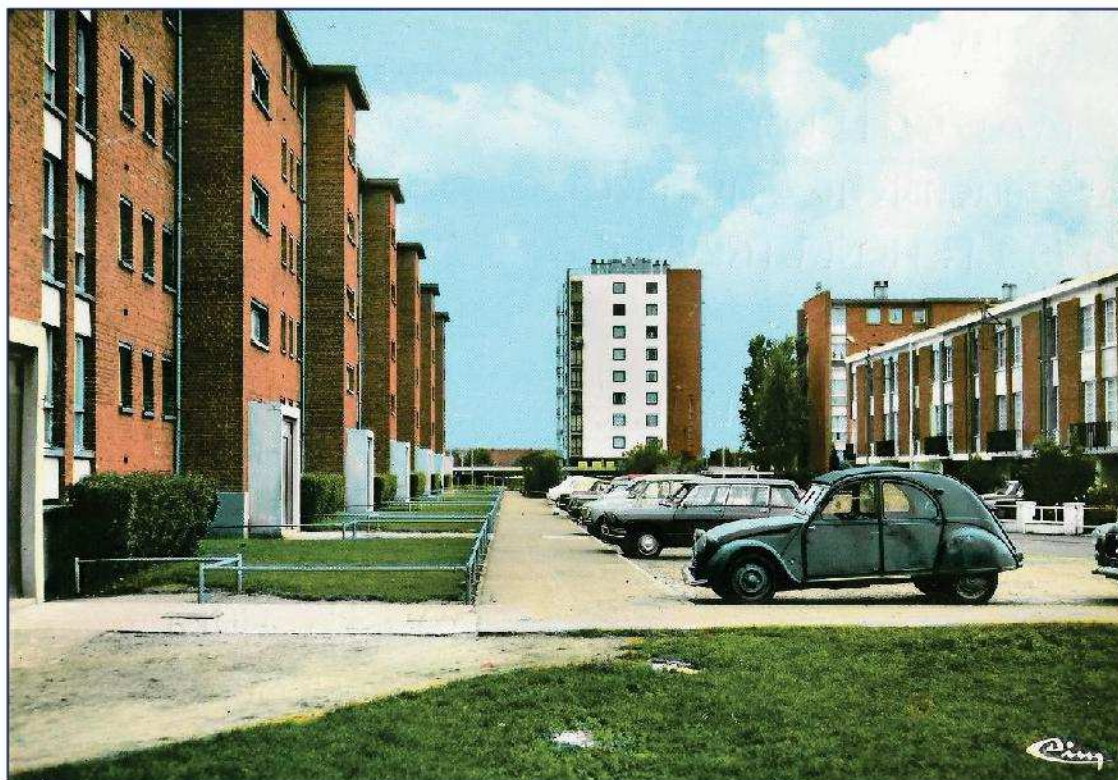
La Tour Coquelicot, vue de la rue Marcel Pinchon
