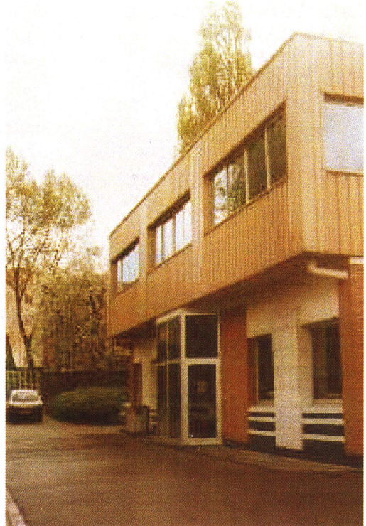
Ci-contre le bâtiment de Mons-en-Barœul, situé au rue du Général de Gaulle, lors de sa construction
