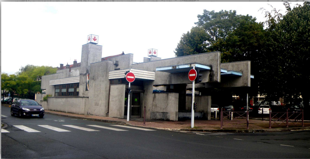
Station des Sarts. Architecte ESCUDIÉ
