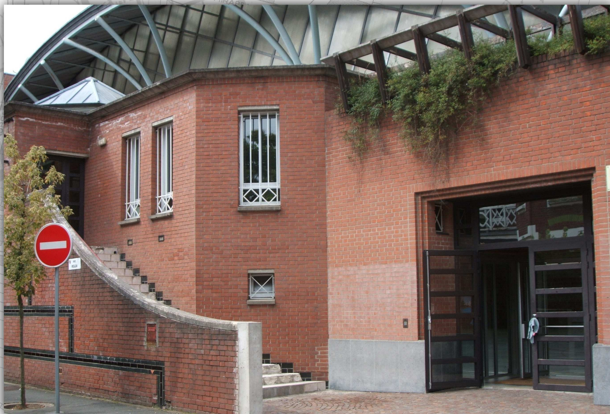
Entrée de la salle de sports Léo Lagrange
