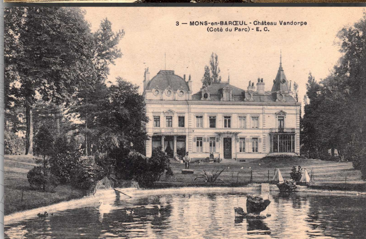
Château Vandorpe côté parc (détruit)
