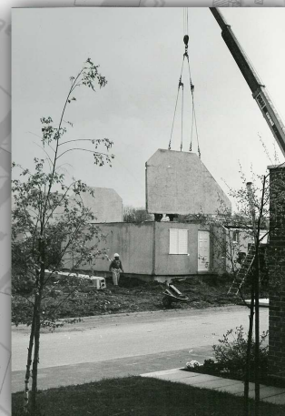
Pose des murs porteurs
