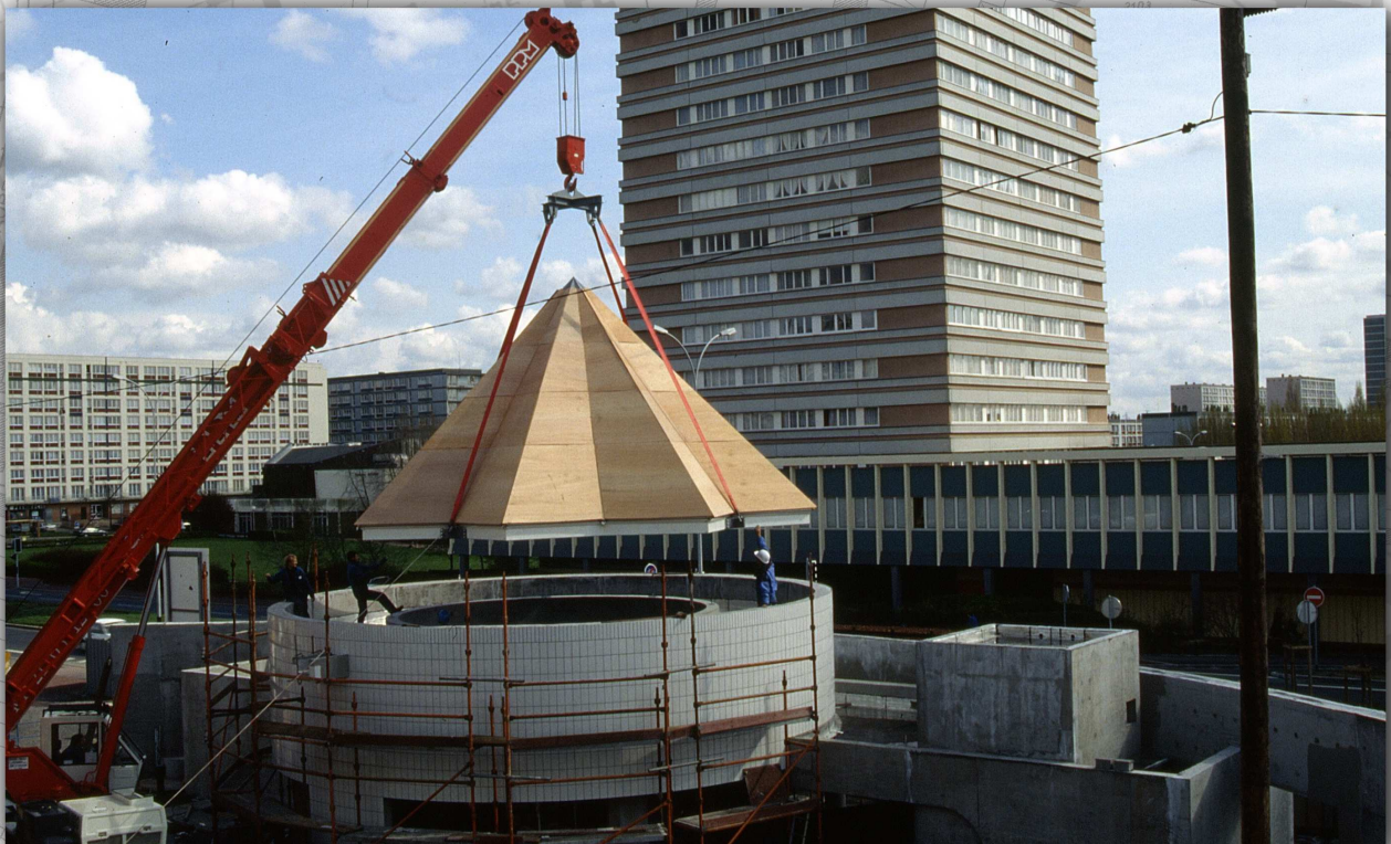
Mise en place du dôme
