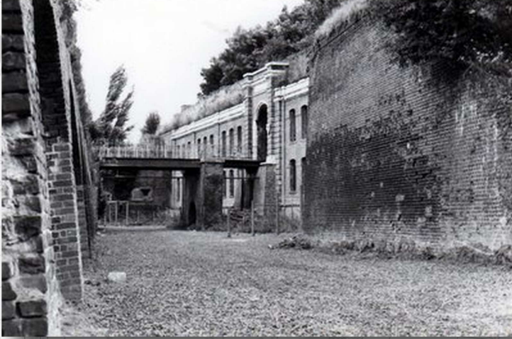
Entrée du Fort et fossés
