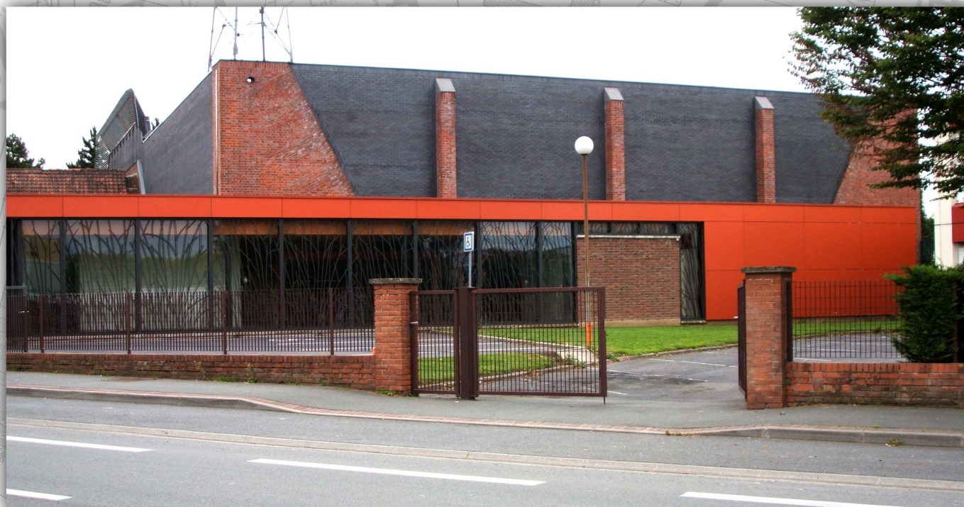
Travaux terminés en septembre 1996
